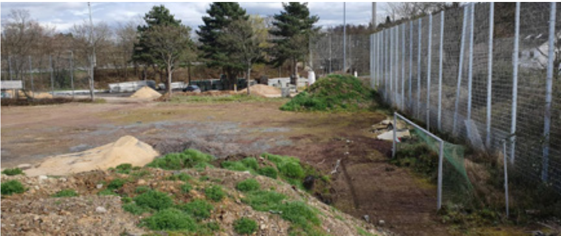
Der Sportplatz in Bad Neuenahr-Ahrweiler, Stadtteil Bachem, ist von der Flut im Juli 2021 komplett zerstört worden. Der neue Sportplatz soll Ende 2024 fertiggestellt werden.
