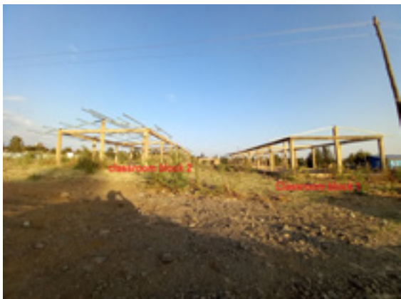
Bereits der Start des Bauprojektes hat zu einer gesteigerten Motivation bei den Kindern und Jugendlichen sowie den Lehrkräften der bestehenden Schule geführt.
