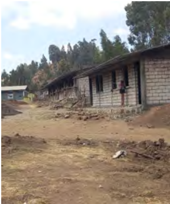
Im Rahmen des Neubaus entstehen moderne Klassenräume und Verwaltungsgebäude.
