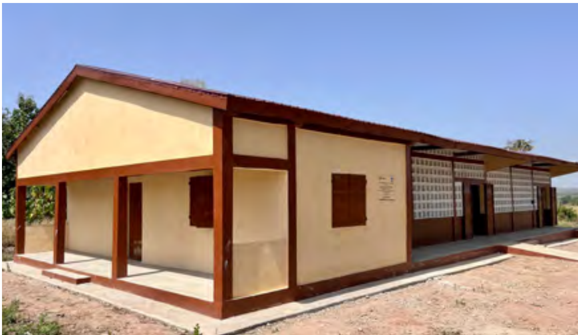
Der neu errichtete Schulkomplex in Yakougmodo verbessert die Lern- und Bildungsbedingungen für rund 210 Kinder nachhaltig.
