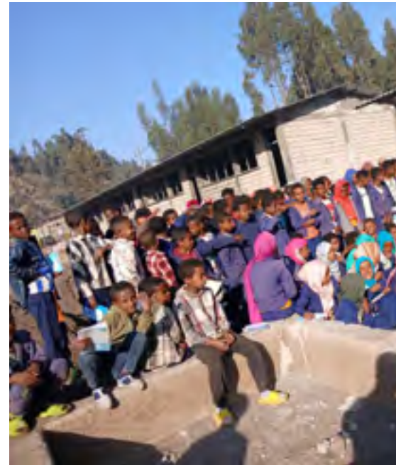
Die Schüler profitieren bereits während der Bauphase von den Fortschritten des Schulneubaus.
