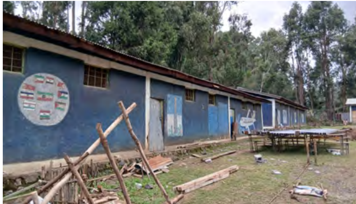
Die Degaga Higher Primary School wird umfassend erneuert und nach modernen Baustandards als sicherer Lernort ausgebaut.
